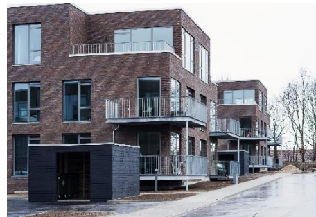
Himmelev Have, Roskilde 74 ejerlejligheder og rækkehuse, ca. 9.000 m 2
