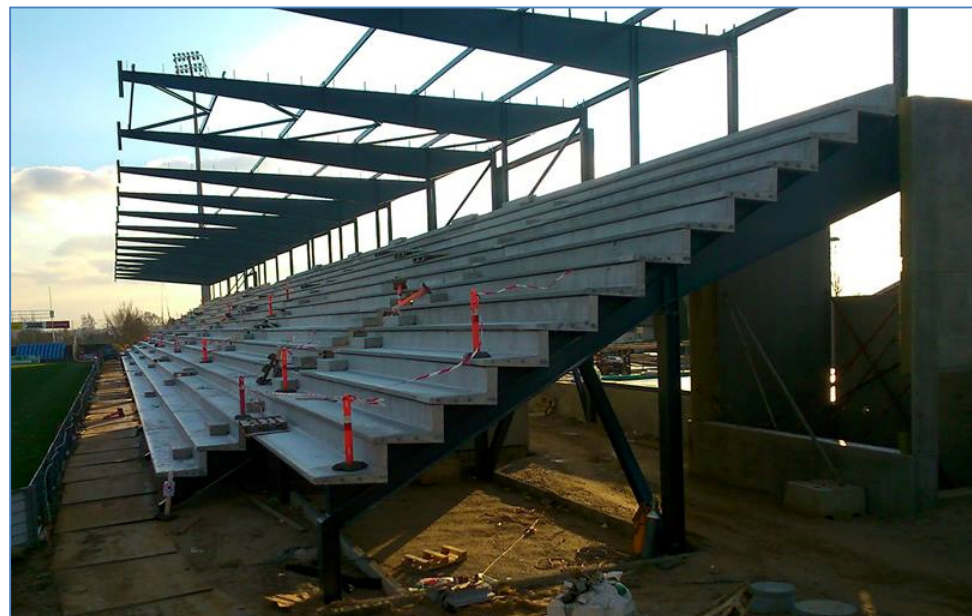
Den nye tribune under opførelse på Sydbank Park. Foto: EUupdates
