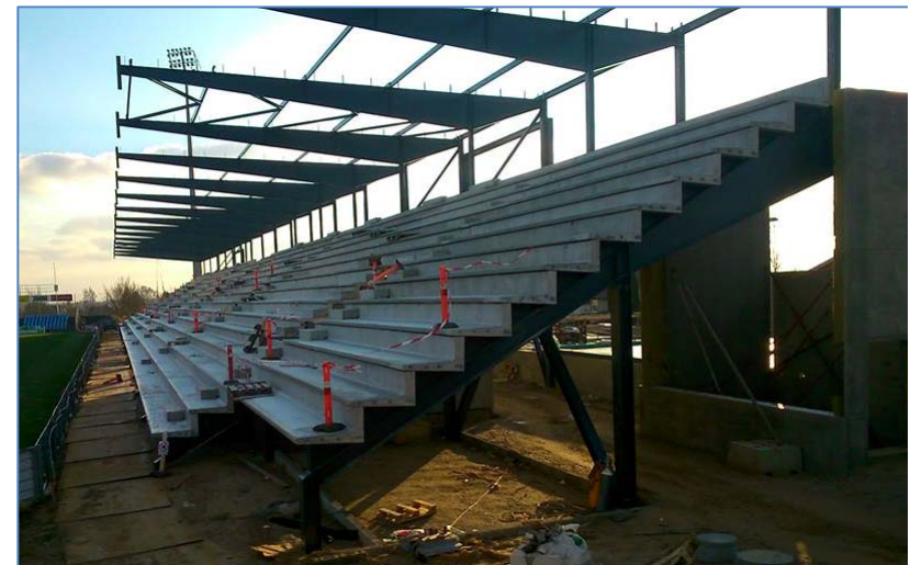
Den nye tribune under opførelse på Sydbank Park. Foto: EUpdates
